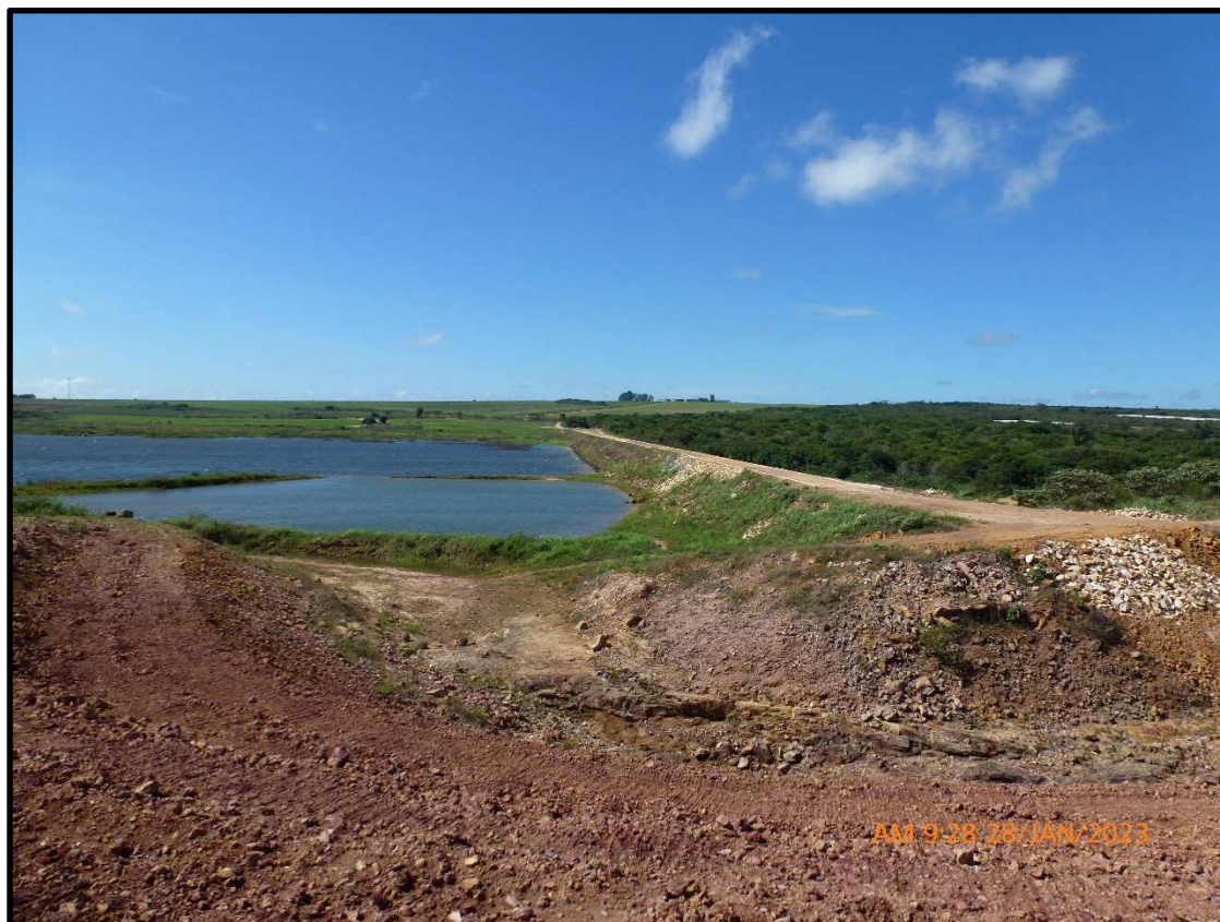
Figura 4.13 – RH3 – Açude Granjeiro/Ibiapina-CE – Represa da Serra da Ibiapaba
